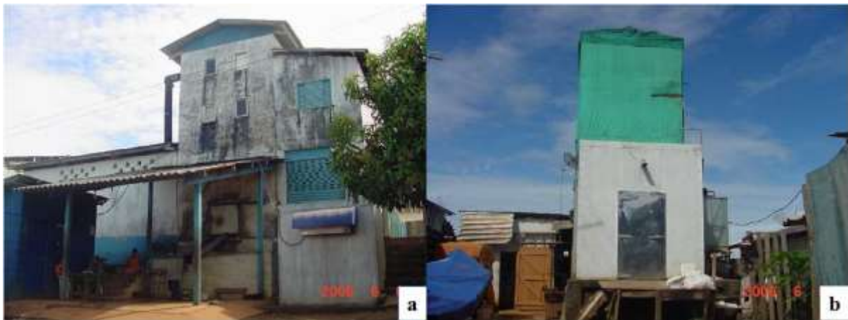
Figura 10. Vista das fábricas de de Gelo E (a) e Fábrica de Gelo F (b), em Tucuruí.
